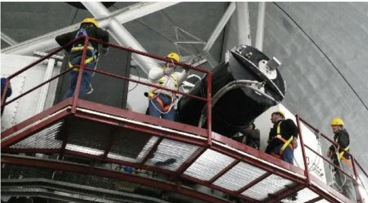
*El instrumento CIRCE siendo instalado en el foco Cassegrain plegado E (Folded Cass E, o FC-E) del telescopio GTC a principios de diciembre de 2014.*
