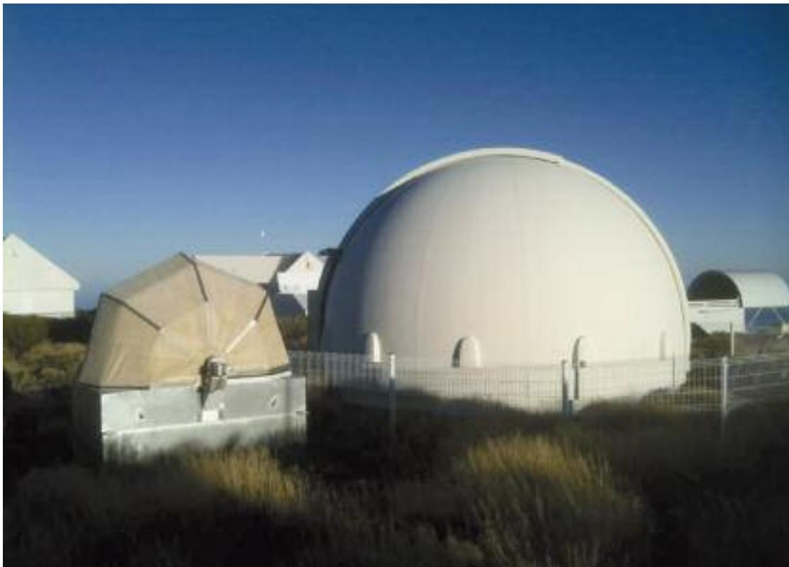
*Infraestructura desarrollada en el OT para las pruebas de la estrella guía láser. A la izquierda: cúpula y caseta del receptor; a la derecha: cúpula de enseñanza, con el equipamiento necesario para el transmisor láser.*
