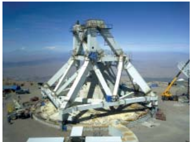
Base de la estructura del GTM. Foto: GTM.
