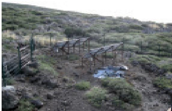
*DIMMA-ORM: Vista de los dos grupos de paneles solares, el inicial y el añadido de cara a duplicar la energía solar entregada al sistema.*
