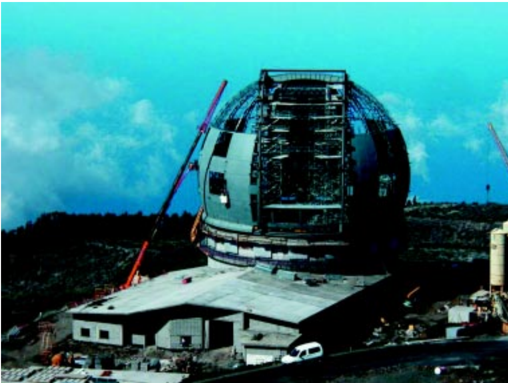
Estado de la cúpula en noviembre de 2001.
