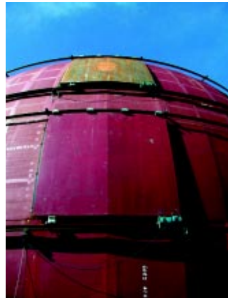
Arriba, instantáneas del transporte por carretera y de trabajos en el interior de la cúpula. Abajo, imágenes de la cúpula del telescopio donde se pueden ver los huecos de ventilación y las compuertas.
