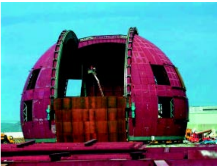
Arriba, instantáneas del transporte por carretera y de trabajos en el interior de la cúpula. Abajo, imágenes de la cúpula del telescopio donde se pueden ver los huecos de ventilación y las compuertas.
